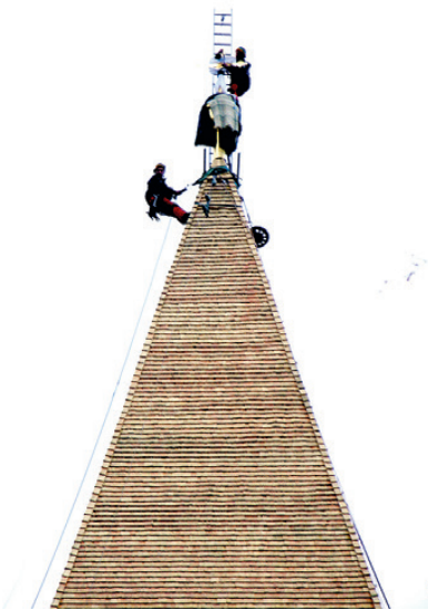
Mitarbeiter der Fa. Pondorfer am neu gedeckten Turmdach (ohne Gerüst!) beim Aufsetzen der Turmkugel, 2004 Foto: A. Eder
