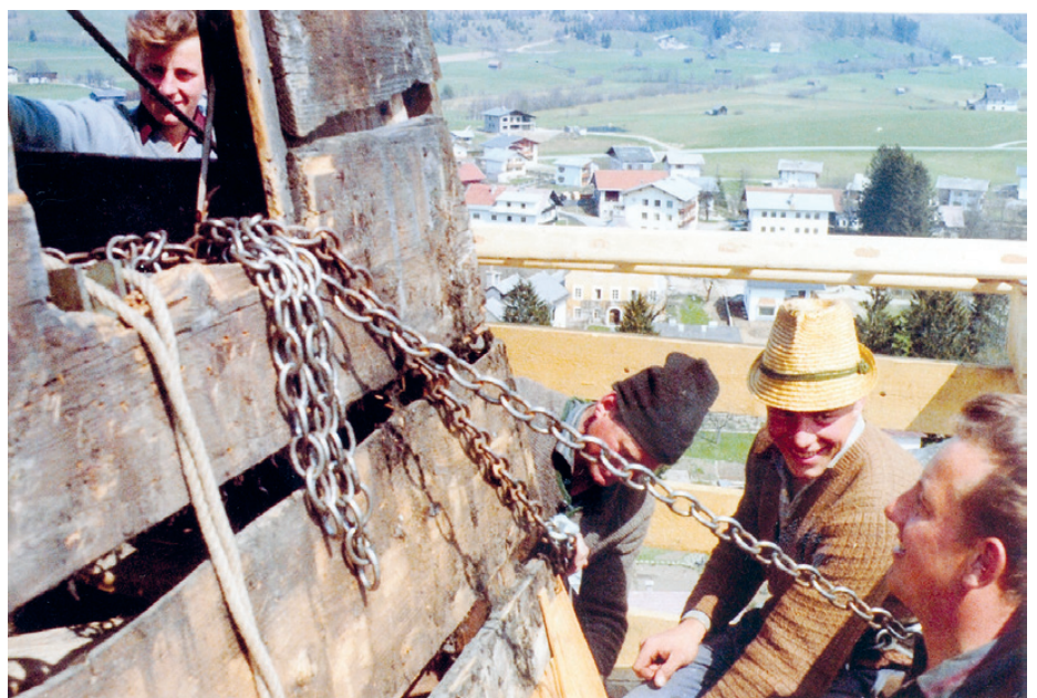
Mitarbeiter der Zimmerei Hartl anlässlich der Neueindeckung 1967 (mit Gerüst) bei der Arbeit: Engelbert Eder, Adam Hirschbichler, Franz Etzer und Hans Heugenhauser Foto: Hans Hartl
