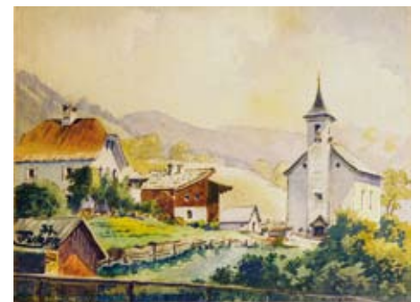
Viehhofen – Pfarrkirche, erbaut 1796/97, mit Pfarrhof und Krämerhäusl; Aquarell von Vinzenz Putzer, 1937
